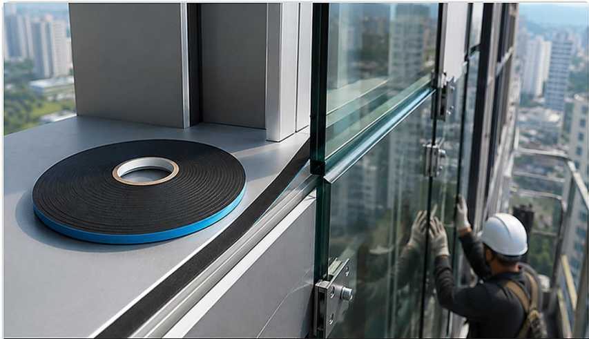
Aplicación en instalación de vidrio para muro cortina
